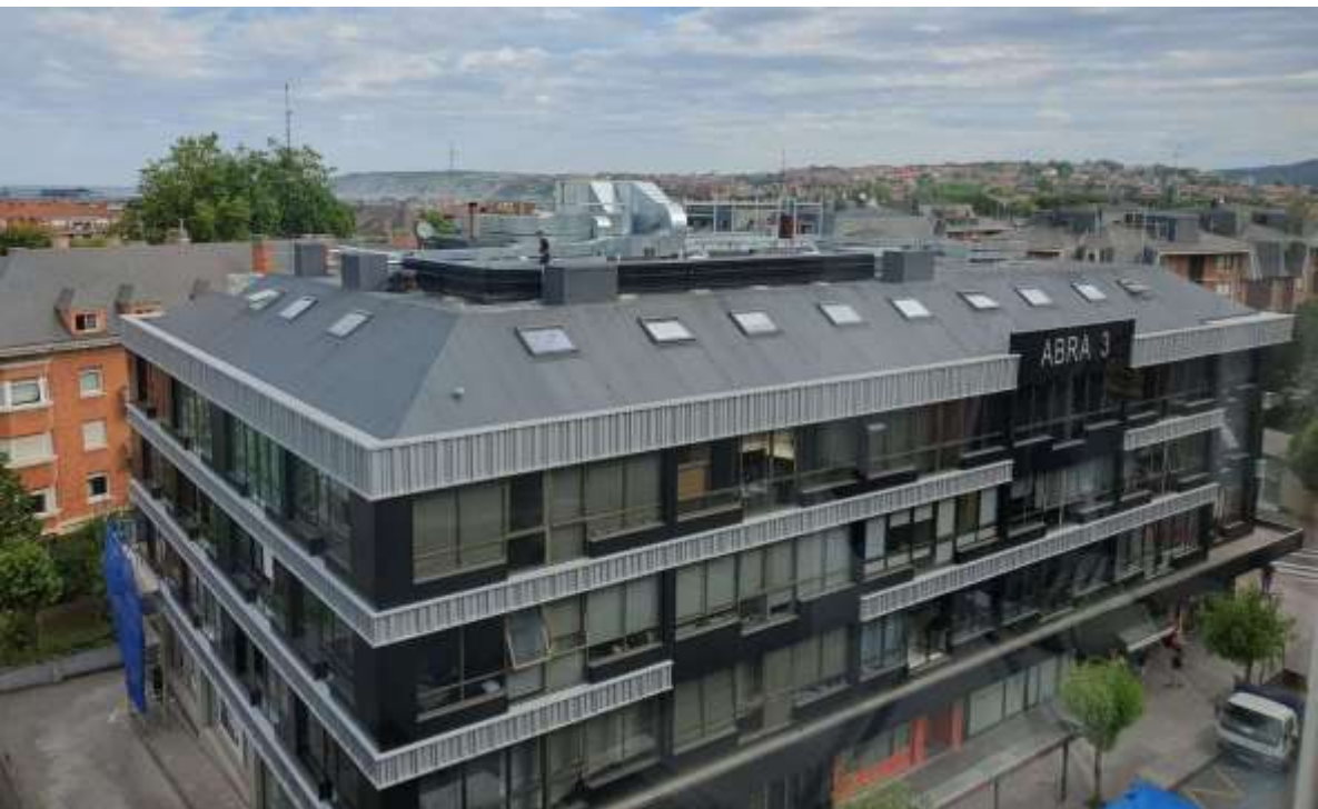
Rehabilitación de la fachada y cubierta de Edificio Terciario en Getxo (Edificación Residencial)
