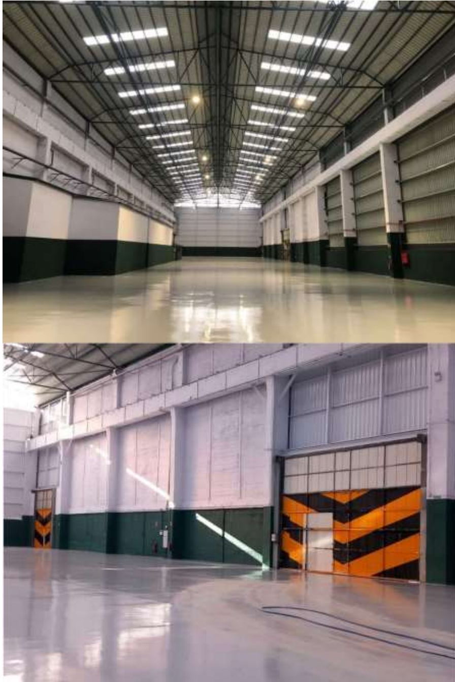
Edificación industrial en Basauri (Rehabilitación integral)
