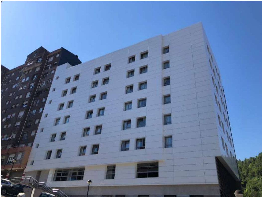
Rehabilitación de la fachada de la Residencia Gazteluondo de Rekalde en Bilbao (Rehabilitación No Residencial)
