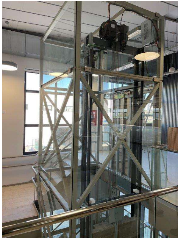
Edificación industrial en Etxebarri (Rehabilitación integral)
